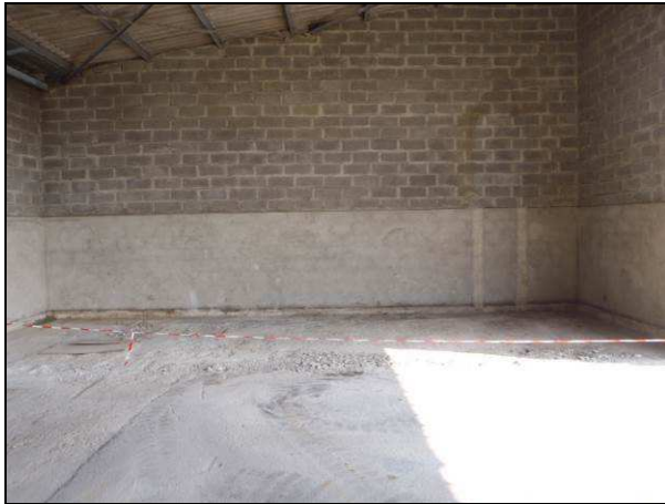
Photographie 9 : Ancienne zone du bac de traitement (18 juillet 2013)
