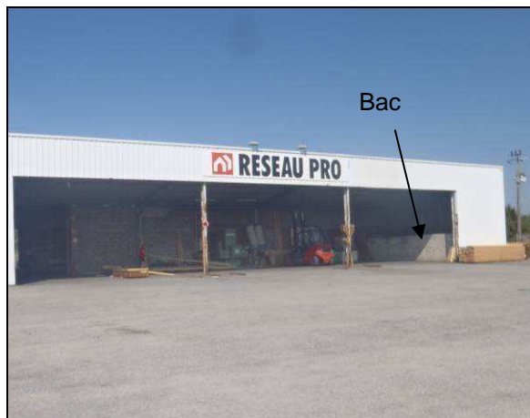
Photographie 3 : Auvent accueillant le bac de traitement (août 2011)
