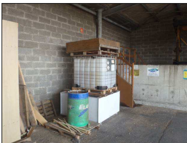
Photographie 5 : Transicuve d'1 m 3 de produit pur sur rétention (août 2011)
