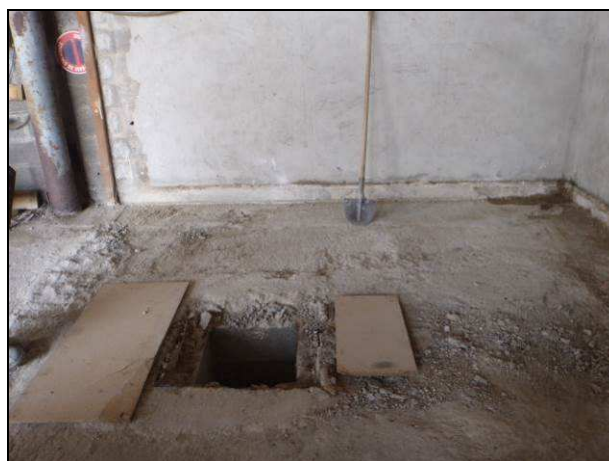
Photographie 8 : Regard découvert sous l'ancien bac de traitement (eaux pluviales ?) (18 juillet 2013)
