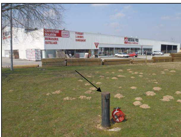
Photographie 19 : Pz3 situé au Sud-Est du site
