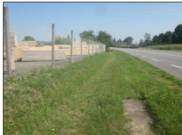
Photographie 14 : Fossé récoltant les eaux pluviales à l'Est du site
