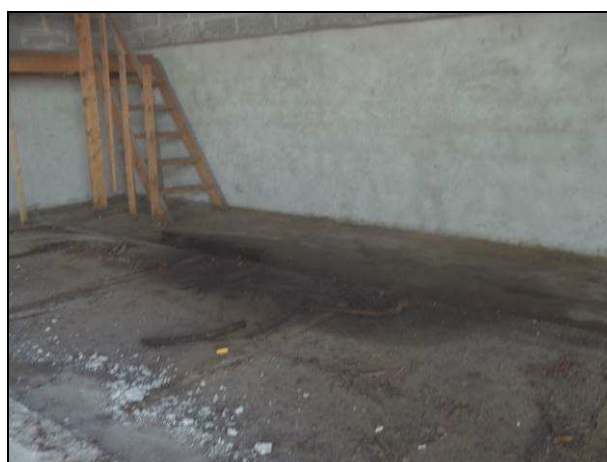
Photographie 6 : Emplacement de l'ancien bac de traitement après démantèlement (12 juillet 2013)
