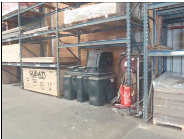
Photographie 13 : Réservoir aérien de 1 m 3 de GNR pour l'alimentation des chariots élévateurs
