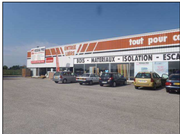
Photographie 2 : Partie Sud-Est du bâtiment avec le magasin et le parking VL
